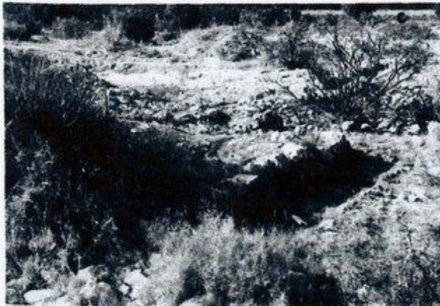
Primer trabajo de limpieza del terreno. Se saca la estructura de un muro.
