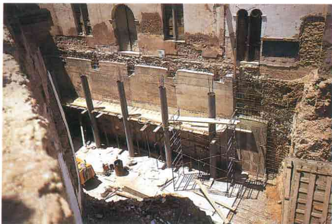
Fig. 11. Salón de actos en construcción.
