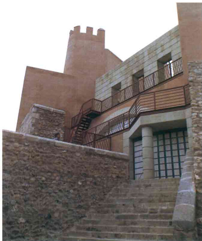
Fig. 17. Fachada nueva entre las torres III y IV.
