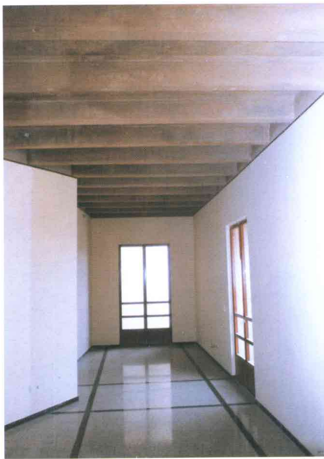
Fig. 25. Vista interior de una estancia donde se aprecia el techo de hormigón in situ y el suelo de terrazo con líneas de mármol negro.
