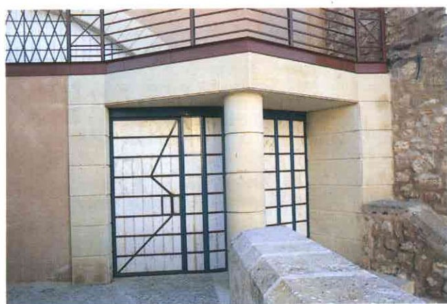
Fig. 16. Puerta de acero y mármol, corredera en su totalidad con una hoja abatible, para acceso al hall del salón de actos.
