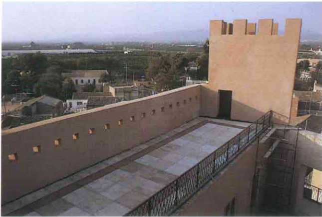
Fig. 19. La torre IV —que posee en su interior la bomba de calor que calienta el suelo radiante de todo el edificio— y el "paseo de ronda".
