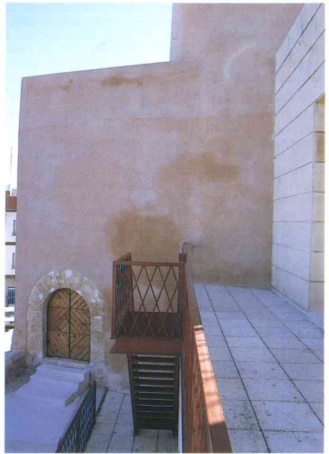
Fig. 24. El arco de antiguo acceso con pavimentos exteriores hechos in situ y paramentos ya revocados.
