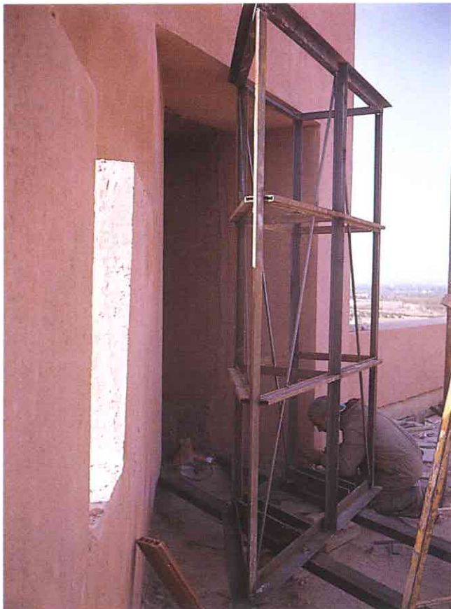
Fig. 26. Dos fotografías de la puerta de salida a terraza de la torre VI ("trozo de muro" que se desplaza oblicuamente sobre unos rodamientos).
