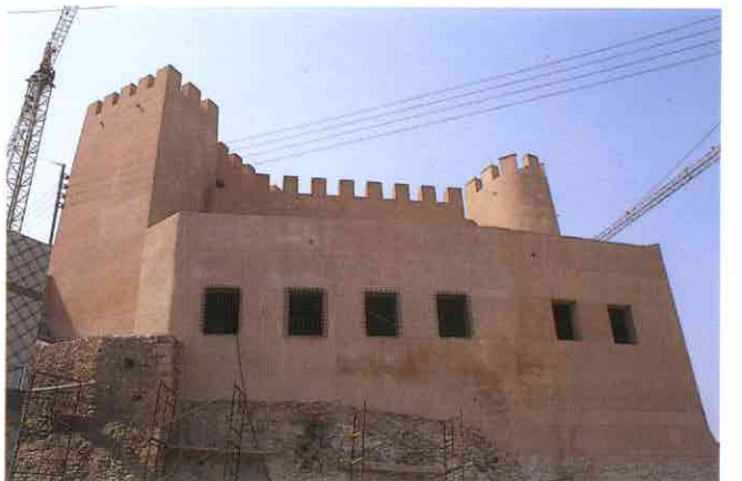
Fig. 21. La zona de habitaciones de los marqueses una vez eliminada la planta superior, que deja ver tras de sí las almenas antes ocultas bajo la cubierta de tejas.
