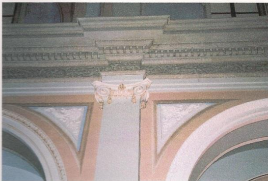
Fotografía nº 22. Detalle de uno de los muros laterales
