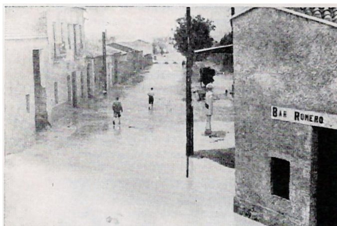
Una vista dels efectes de la riuada del 28 de setembre de 1949. En la foto el carrer de la carretera de Nàquera.
